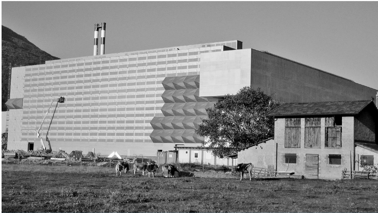
Imposantes Gebäude inmitten landwirtschaftlicher Idylle: Die Schornsteine der Kehrichtverbrennungsanlage erreichen über 55 Meter Höhe
