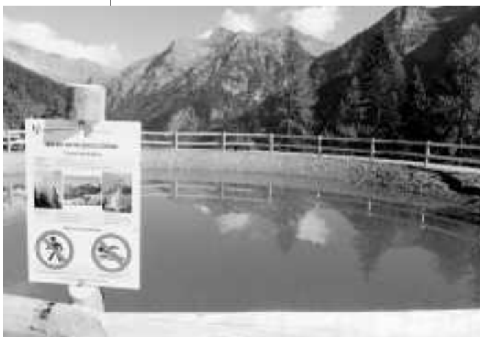
Neu angelegt: Wasserfassung für Helis im Falle von Waldbränden
