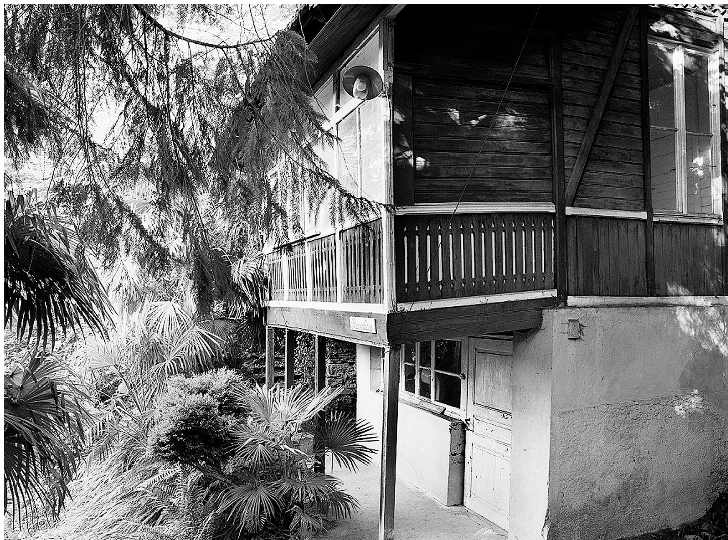
Das Russenhaus wurde im Stile der ersten Bauvariante renoviert, mit viel Engagement und Zurückhaltung
