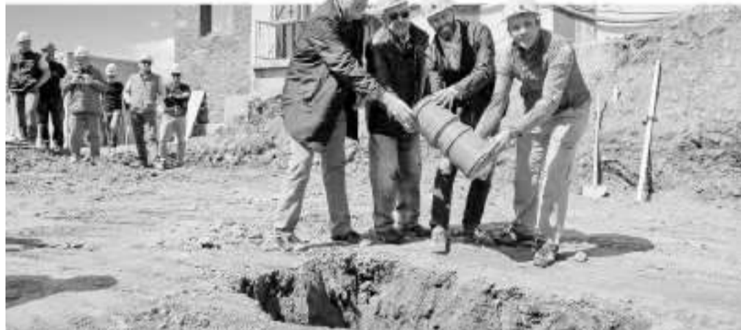
Ein von Gemeinde, Patriziat und SAC unterzeichnetes Dokument erinnert an den Baubeginn
