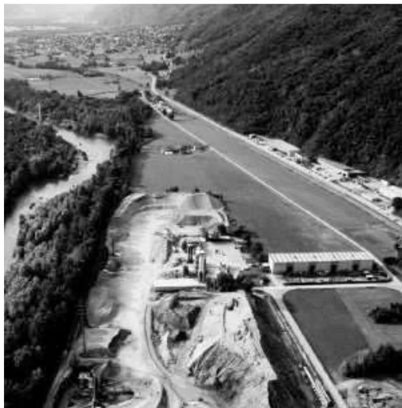
Hier sollte bis 2026 die neue SBB Werkstätte entstehen
