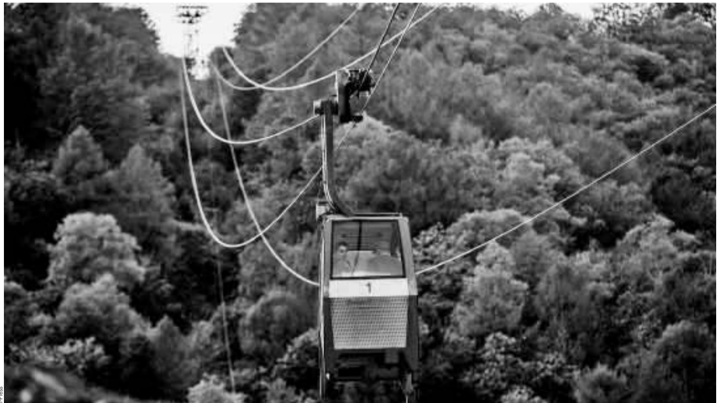
Eines der wichtigsten Förderprojekte des Masterplans wäre die Sanierung der beiden Seilbahnen Intragna-Costa und Verdasio-Rasa
